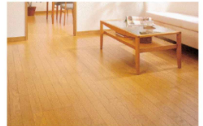
3 複合フローリング 12mm厚 施工例
